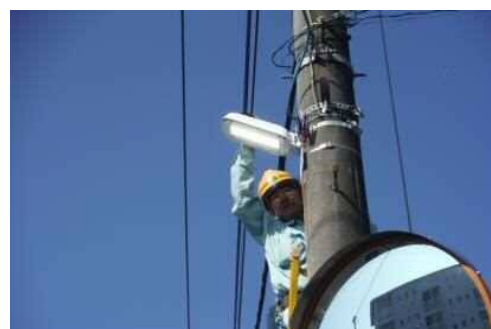
公衆街路灯修繕
