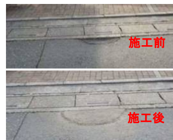
道路緊急修繕
