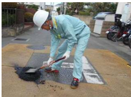
【道路緊急修繕】
