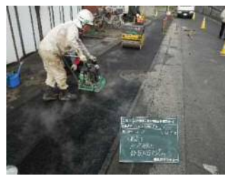
土木緊急修繕
