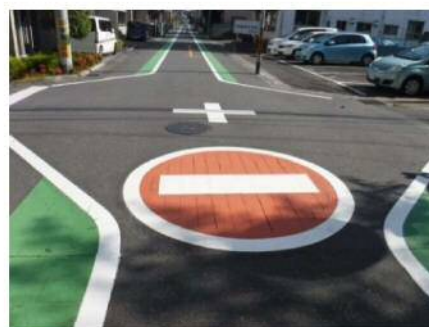
路面表示修繕後の様子
